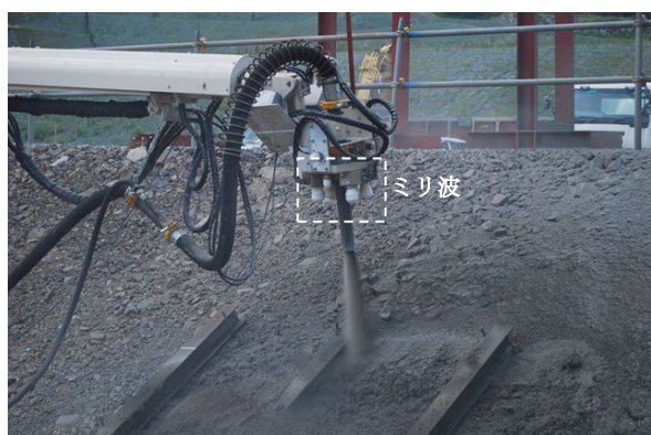
図 1. ミリ波レーダによる吹付け時の距離計測
