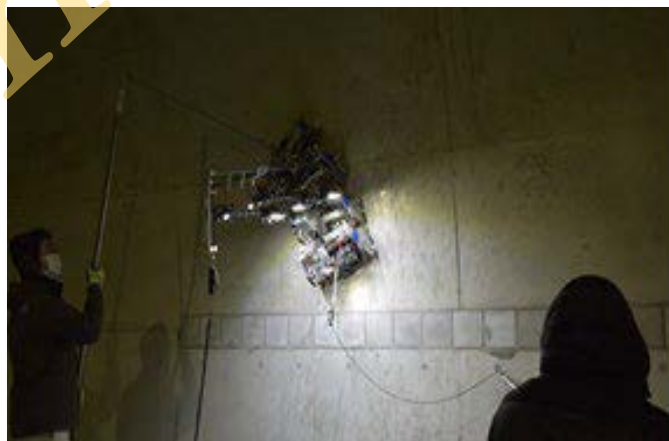
トンネル模擬施設での走行
