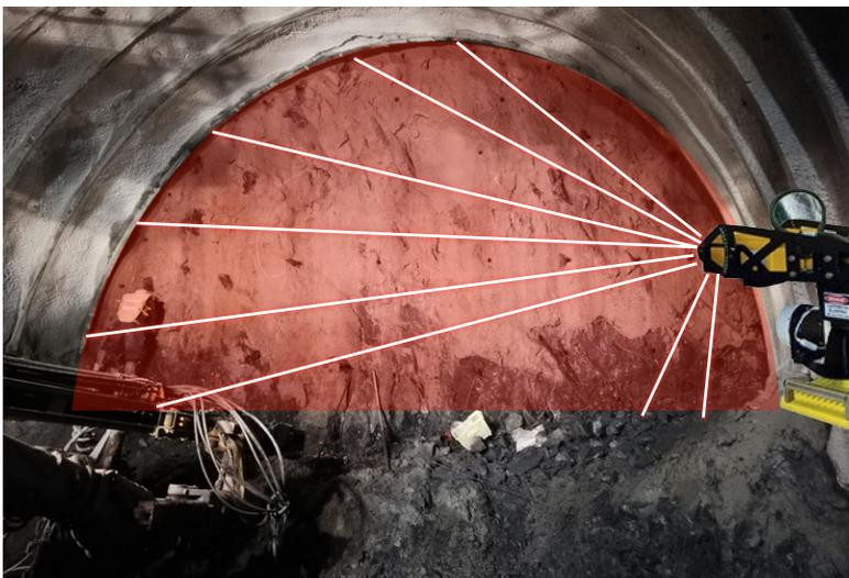
レーダーは計測ヘッドを左右に動かし切羽をスキャンします。稼働中の重機、人の計測データは自動でキャンセルします。
